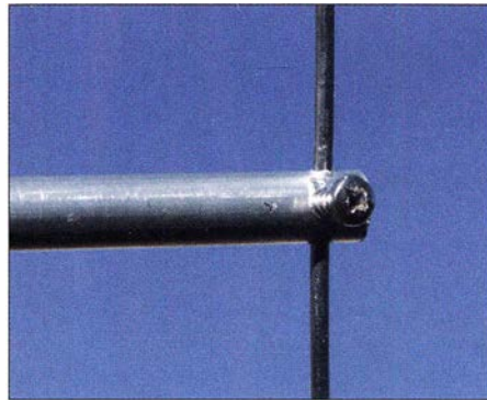
Bild 6: Montage der Endkapazitäten zur Verkürzung des 6-m-Dipols
