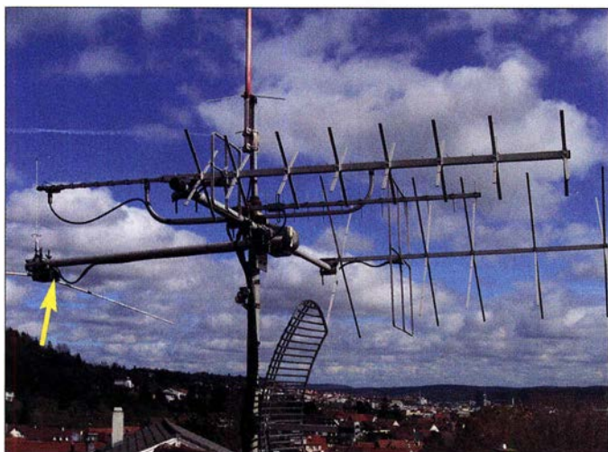
Bild 1: Die Antennenanlage bei DC4CX; links ist ein Dipol für das 4-m-Band an einem Ausleger erkennbar.
